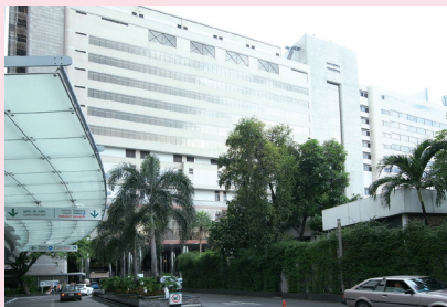
バムルンロード病院 外観 (バンコク)
